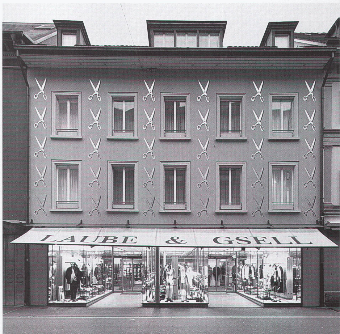
Ansicht Fassade Vue de la façade
