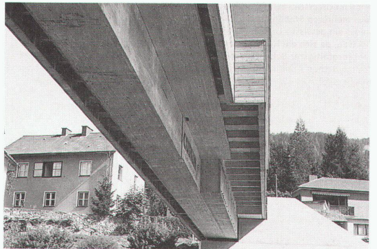
Produktion des Untergurts aus Brettschichtholz ■ Fabrication de la membrure basse en bois lamellé ■ Production of the laminated wooden bottom boom Foto: Marcel Meili, Zürich
