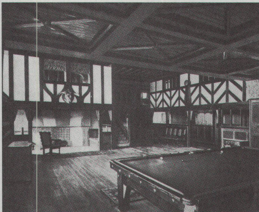
Halle Landhaus «Clouds»; Architekt: Philip Webb
