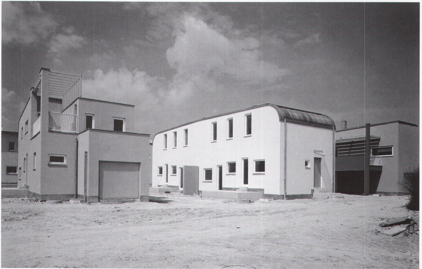
Siedlung Pilotengasse, Wien, 1992 Architekten: Herzog & de Meuron, Basel; Steidle + Partner, München; Adolf Krischanitz, Wien Einfamilienhäuser am östlichen Siedlungsrand projektiert von Adolf Krischanitz, Wien ■ Ensemble Pilotengasse, maisons familiales à la périphérie est de l'ensemble ■ Pilotengasse development, detached houses on the eastern edge of the development Foto: Margherita Spiluttini, Wien
