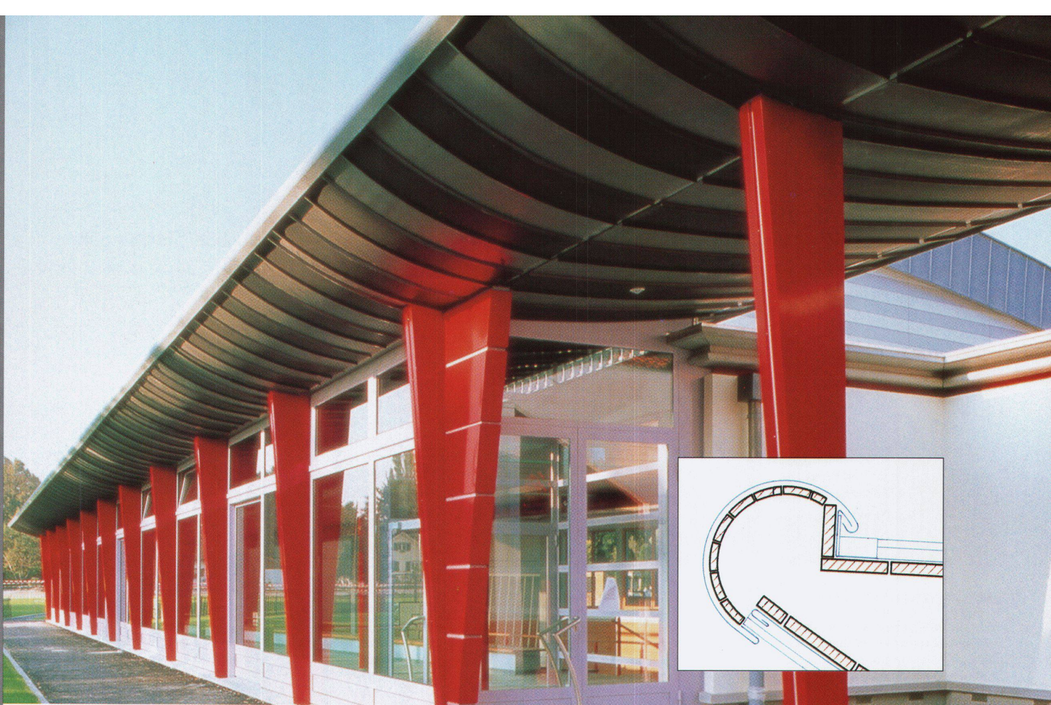
Salle de gymnastique, 1294 Genthod. Architekten: Redard-Barro-Haldinger, 1227 Carouge. Spengler: Cerutti Toiture SA, 1226 Thônex.
