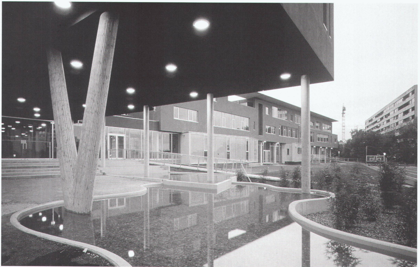
Quertrakt über dem Eingang, von Osten
