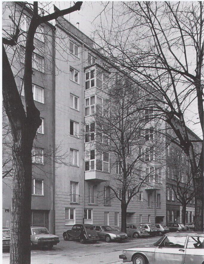
**Entwicklung von Hof- und Strassenfassade, ausgehend von den nach unten höher und schmaler werdenden Fensterformaten. Positionierung der Fensterachsen, Einführung von Erkern, Modifikation der Fensterteilung aufgrund von Aussicht, Bedienung und Bauordnung**
