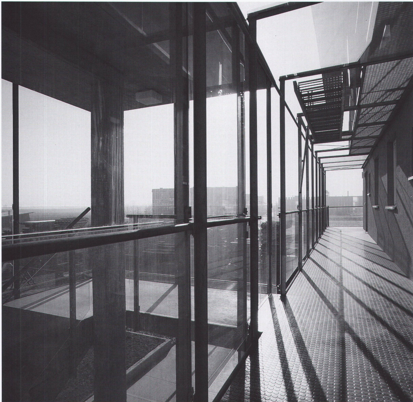
Der balkonartige Laubengang ■ La coursive en forme de balcon ■ The balcony-like arcade
