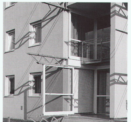
Loggia mit den auskragenden Schiebefenstern ■ Loggia avec fenêtres coulissantes projetées ■ Loggia with projecting sliding windows
