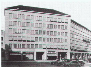
Fassade, Amtshaus V, kurz nach Fertigstellung 1934 Façade, bâtiment des services officiels V peu après son achèvement en 1934
