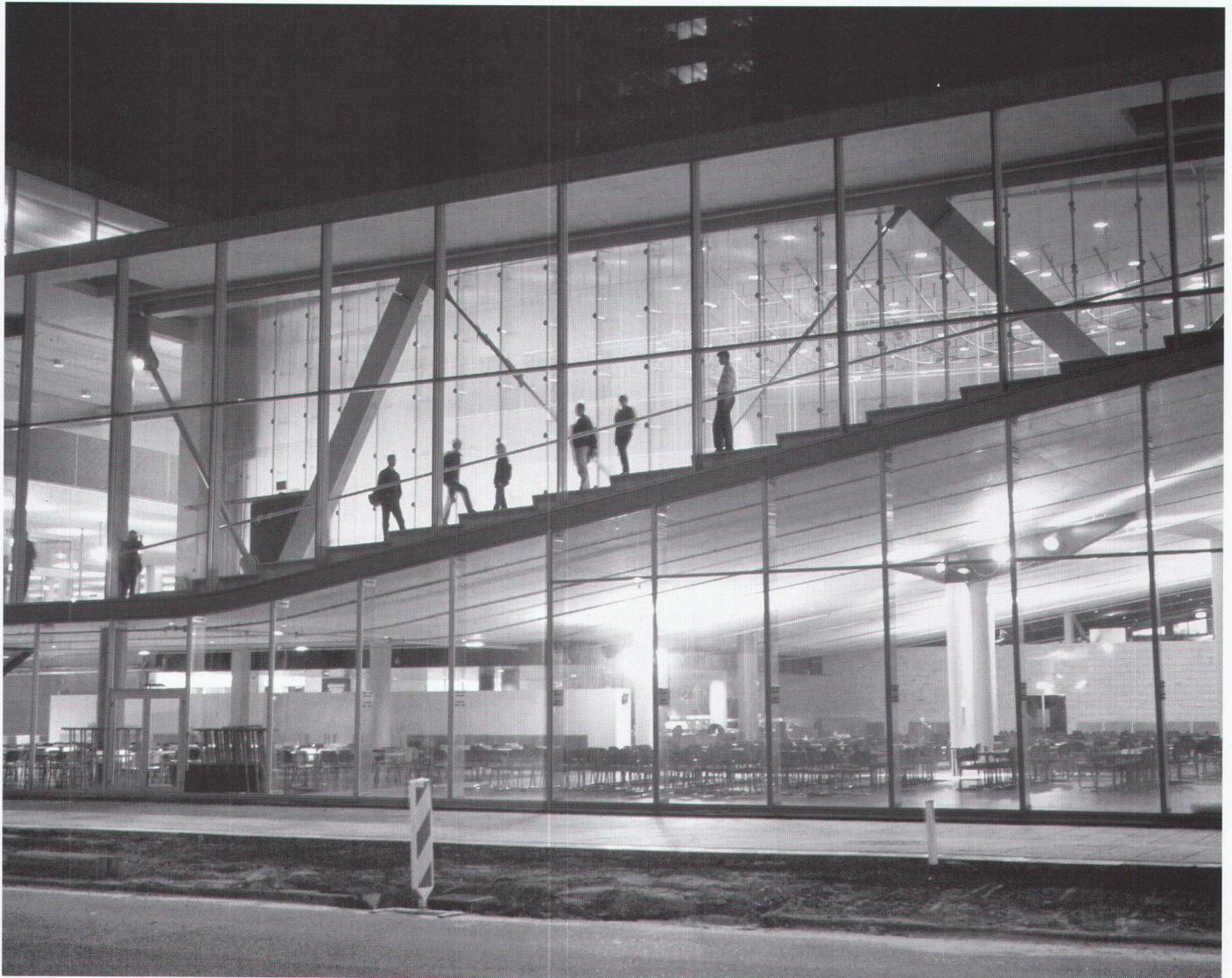
**Ein geschosshoher Fachwerkträger mit Zugstäben aus Stahl und Druckstäben aus Beton ermöglicht in der darunterliegenden Kantine eine unregelmässige Stützenstellung mit einer maximalen Spannweite von mehr als dreissig Metern.**
