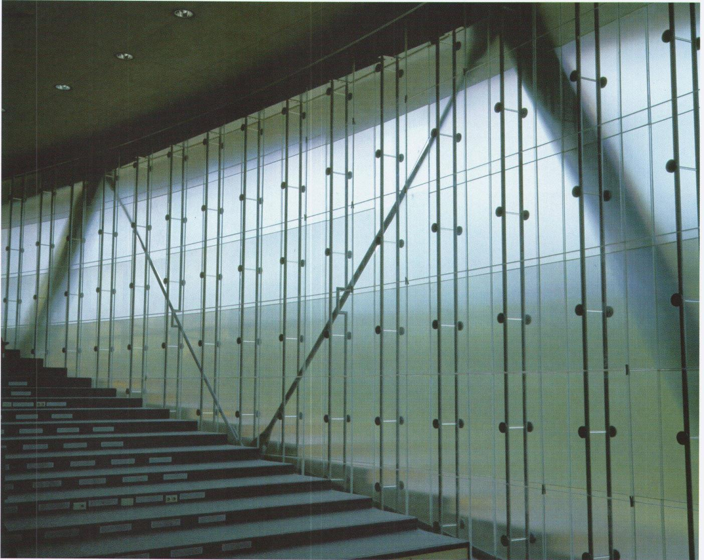
Die doppelte Glashaut zwischen dem grossen Hörsaal und der grossflächig verglasten Nordfassade enthält eine holographische Folie. Sie ist transparent, sofern man frontal hindurchschaut. Je flacher aber der Blickwinkel wird, desto mehr verschleiert sich das Bild: Personen, die auf der anderen Seite entlanggehen, tauchen wie aus dem Nebel auf, sind für einen kurzen Moment deutlich erkennbar und verschwinden wieder.
