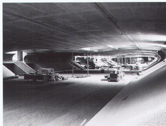
Pavillon der Utopie: Innenraum ▷ Pavillon de l'utopie: espace intérieur ▷ Utopia Pavilion: interior space
