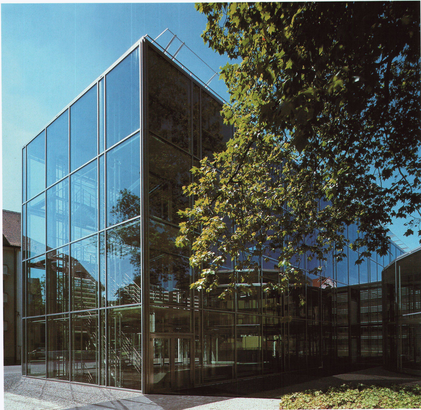
Gebäudekopf am Lorrainepark mit Bibliothek ▷ Volume de tête sur le parc Lorraine avec biblio- thèque ▷ Head-end of the building towards Lorrainepark, with the library
