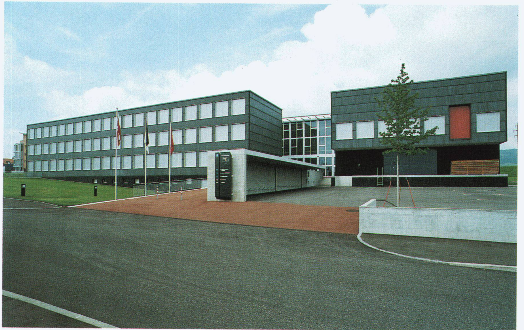
Zugangssituation mit Anlieferung
