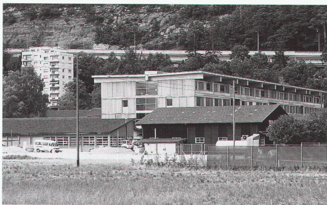
Schweizerische Hochschule für die Holzwirtschaft, Biel, 1999 Architekten: Marcel Meili, Markus Peter mit Zeno Vogel, Zürich Mitarbeit: A. Schmidt, T. Schnabel, O. Villiger, T. Kühne, U. Schönenberger, M. Loeliger Bauingenieure: Conzett, Bronzini, Gartmann AG, Chur ▷ Ecole Supérieure Suisse pour l'Economie du Bois ▷ Swiss School for Wood Industry
