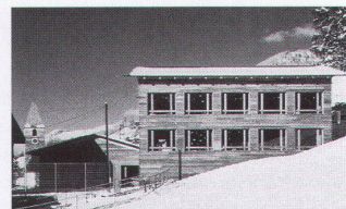
Schulhaus mit Mehrzweckanlage St. Peter, St. Peter GR Architekt: Conradin Clavuot, Chur, 1997–1998
