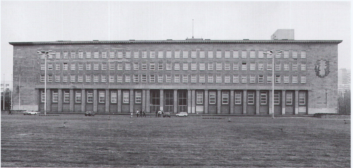
Hauptfassade der ehemaligen Reichsbank vor Baubeginn 1990
