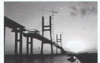
Die Einweihung der grossen Seohae Bridge in Korea ist für das Jahr 2001 geplant
