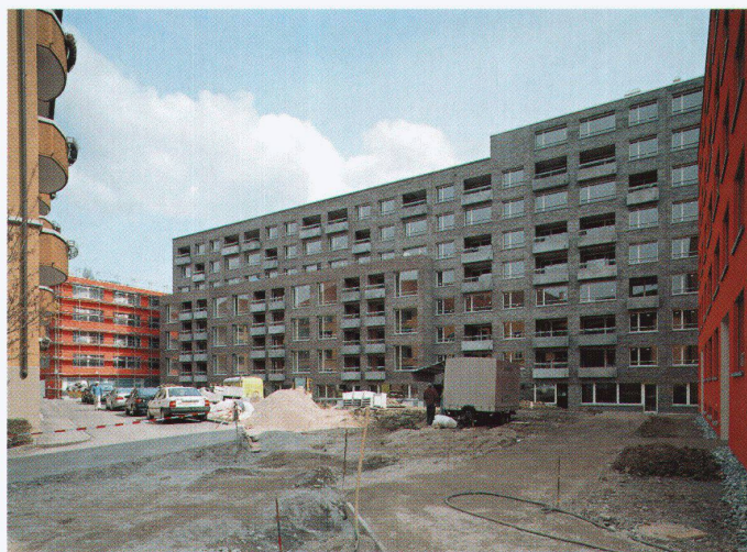
KraftWerk 1, Blick in die Überbauung, von Westen: Haus B2, Haus A, Haus B1
