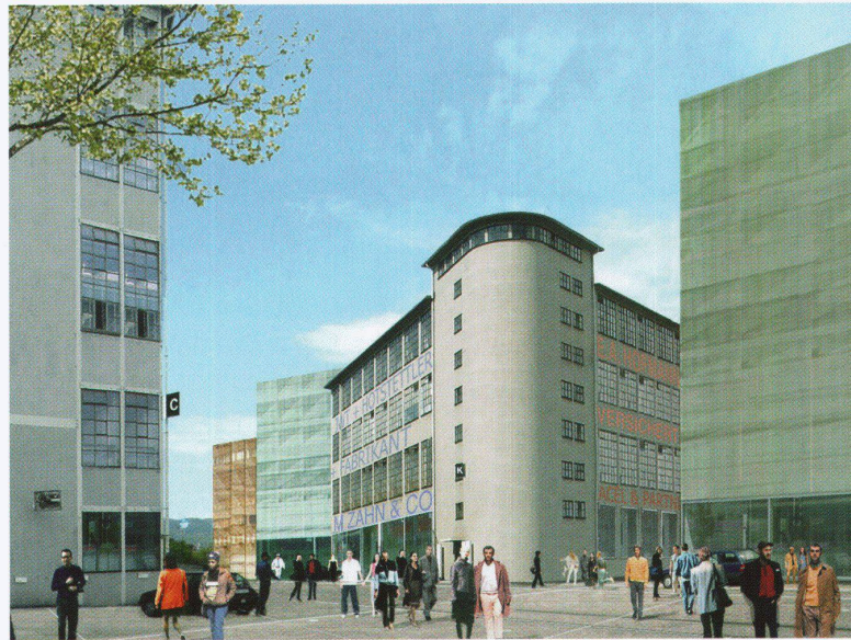
Verdichtung von Bausubstanz aus den 1930er-Jahren
