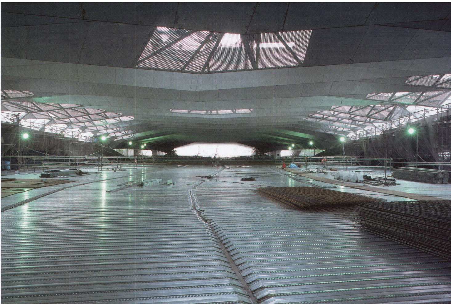
Abfertigungshalle im Bau
