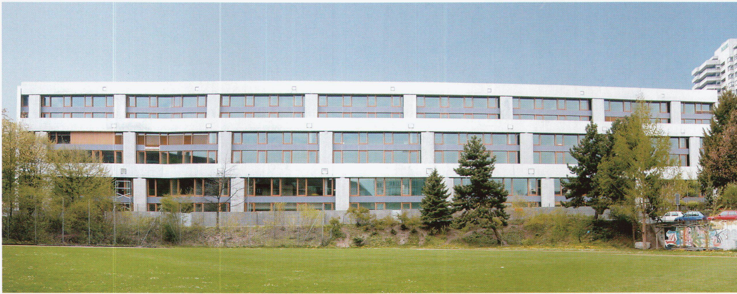
| 1 Stadtfassade im Südosten
