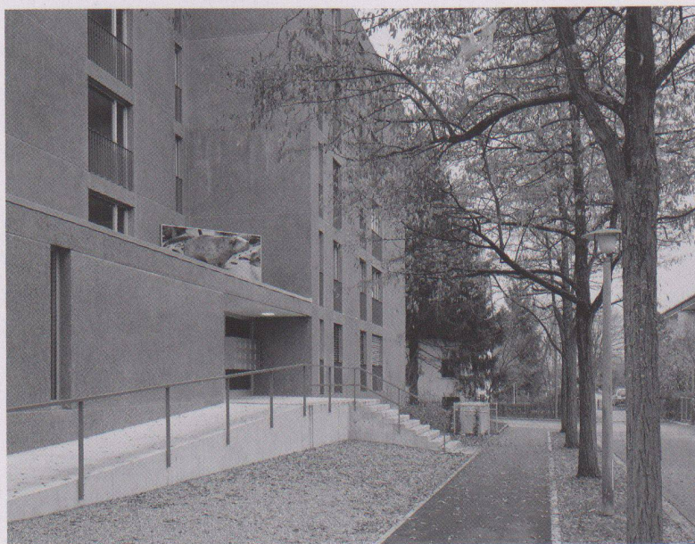
Bilder: Georg Aerni, von Ballmoos Krucker (Baustellenfotos)
