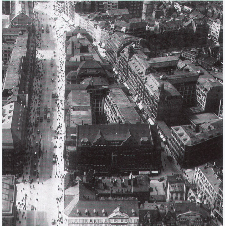
Das «Bach-Viertel» zwischen Spitalstrasse und Mönckebergstrasse, Luftbild um 1930. Das Semperhaus fällt durch die drei Kuppeltürmchen auf. Nach links folgt der Barkhof mit dem Südseehaus, dann die Mönckebergstrasse mit dem Levantehaus. – Bild: Landesmedienzentrum Hamburg
