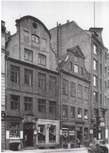
Das Haus Hopfensack 17. Es war eher mittelgross, besass aber mit Hofflügel und rückwärtigem Speicher alle typischen Bestandteile eines traditionellen hamburgischen Bürgerhauses. Aus dem späteren 18. Jahrhundert stammte die Fassade. 1943 wurde es durch Bomben zerstört. Bild: Landesmedienzentrum Hamburg
