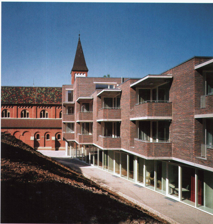
oben: Strassenseite. Die Kubatur fügt sich in die Masstäblichkeit der benachbarten Wohnhäuser ein. unten: Hofseite. Wohnungen mit geschütztem Aussenbereich über dem zusammenfassenden Erdgeschoss mit Gemeindeeinrichtungen.
