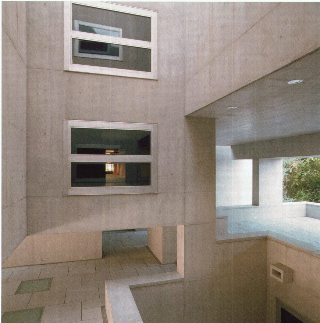
EG, Blick von SO in den Hof
