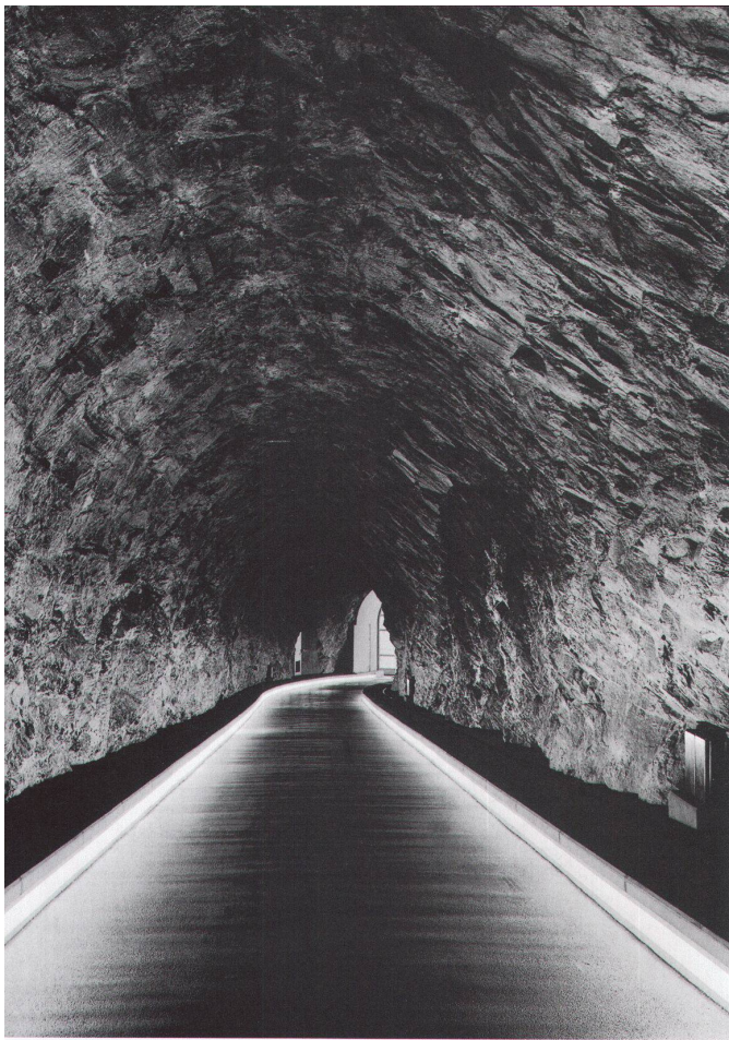
Zugangsstollen Zentrale Ferrera. – Bild: Christian Kerez
