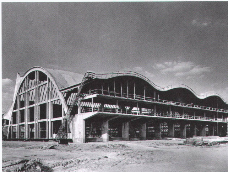
Grossmarkthallen, Verwaltungstrakt im Bau. – Bild: E. Becker-Mosbach
