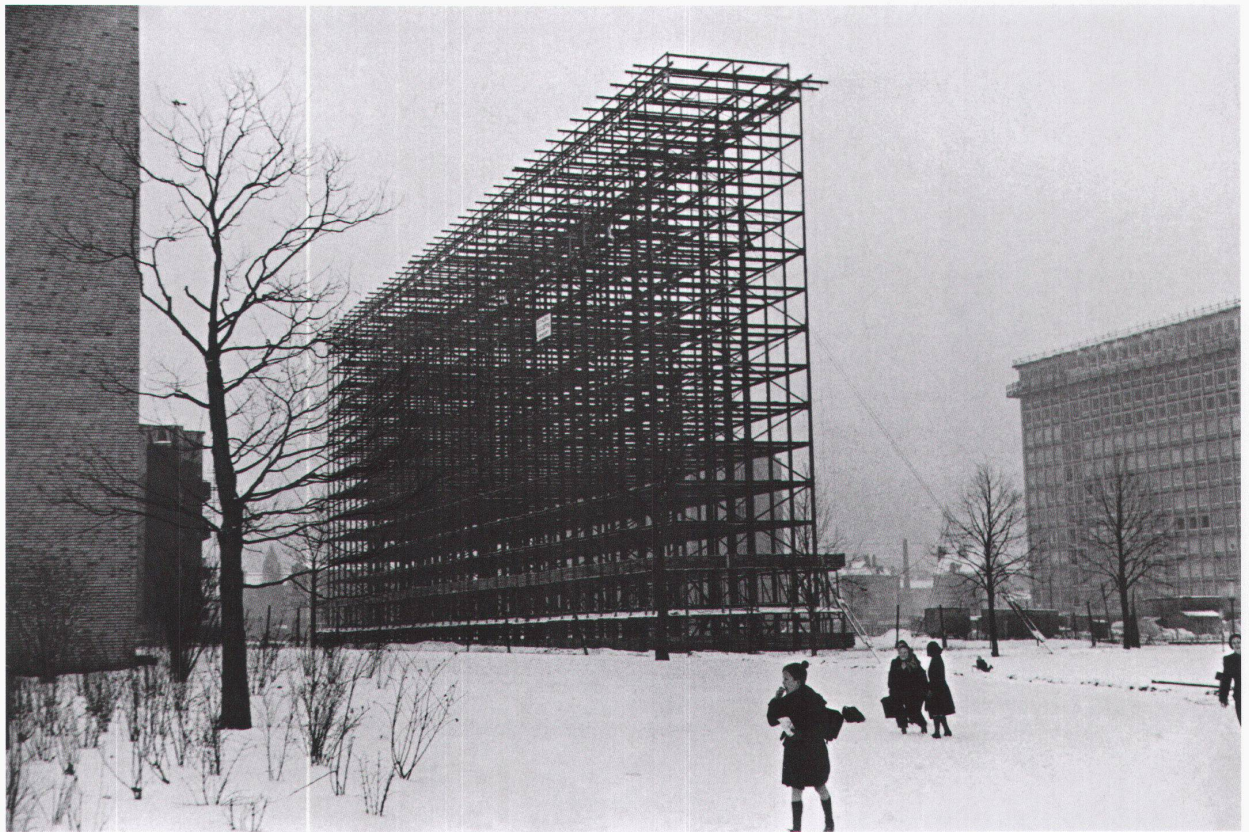
Hochhäuser am Grindelberg im Bau (1952/53). – Bild: ©H. Cartier-Bresson
