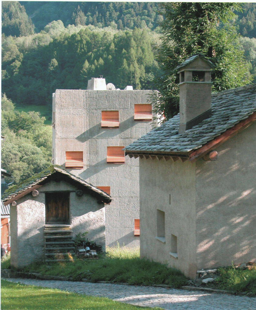
Roccolo, Nordansicht. – Bilder: Nott Caviezel
