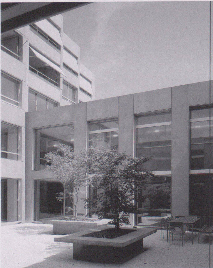
Innenhof mit Wohnungen
