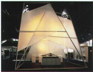
umfassen beispielsweise Überdachungen, Sonnenschutzsegel, Fassadenlamellen, Schirmkonstruktionen und Markisen. Hier überzeugen die Gewebe auch durch eine hohe UV- und Witterungsbeständigkeit sowie durch äusserst hohe Höchstzugkraftwerte bei extrem niedrigen Flächengewichten. In Innenräumen sind es neben den lichttechnischen vorwiegend die akustischen Eigenschaften, welche Präzisionsgewebe von Sefar zum idealen Material etwa für Raumtrenner, Akustiksegel oder Lichtdecken machen.
