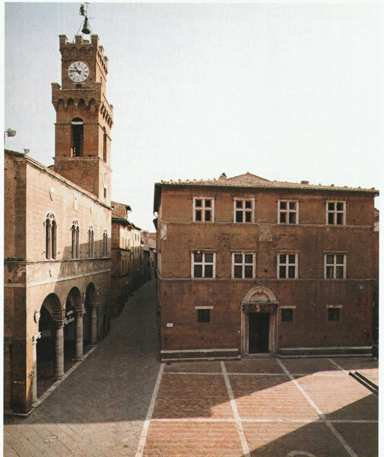
Oben: Bernardo Rossellino, Pienza, «inszenierter» Blick zum zum Papstpalast. Rechts: Blick aus dem piano nobile des Papstpalastes auf Rathaus, Bischofsresidenz und Platzareal
