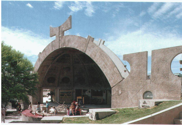
Die Konstruktion von Arcosanti, Arizona. Paolo Soleri, seit 1970. – Bild: Ákos Moravánszky, 1990
