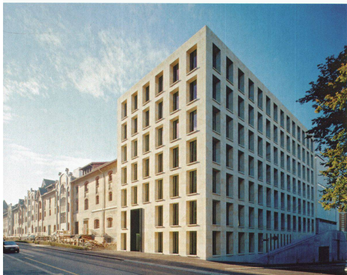
Baumschlager-Eberle: Bürohaus Davidstrasse, St. Gallen
