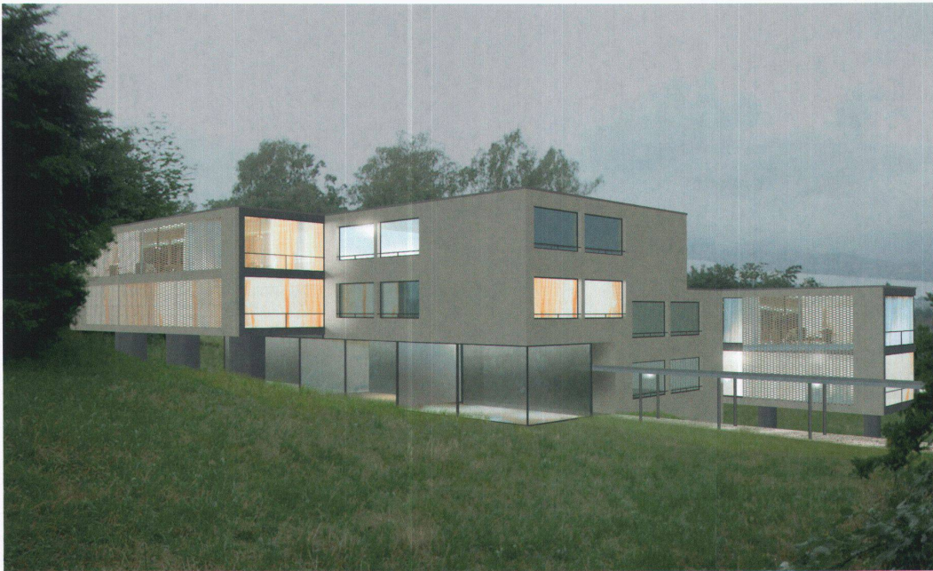
Baufeld «Mittelberg», Projekt Jakob Steib, Zürich
