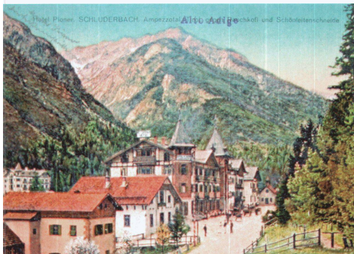
Ehemaliges Hotel Ploner in Schluderbach bei Toblach, nach langen Jahren der Agonie 1982–1984 renoviert und zu Apartments umgestaltet. Der Aufdruck «Alto Adige» über Südtirol stammt aus der Zeit nach 1918, als dieses Gebiet bereits italienisches Staatsgebiet war. Postkarte Sammlung Landesmuseum Ferdinandeum Innsbruck
