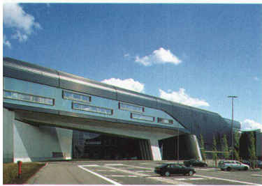
Ansicht Zugang. – Bild: BMW AG. rechts: zentrale Strasse
