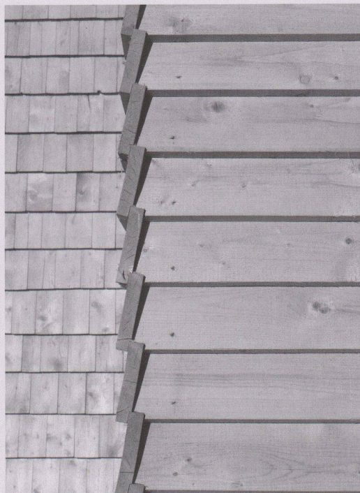
Schalung aus Bohlenbrettern
