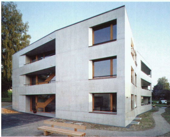
Neff Neumann Architekten, Zürich: Wohnhaus für behinderte Menschen Schoren in Reinach AG
