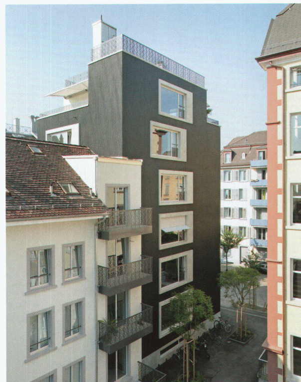
Fassade zur Zurlindenstrasse (oben) und zur Hofeinfahrt (unten)
