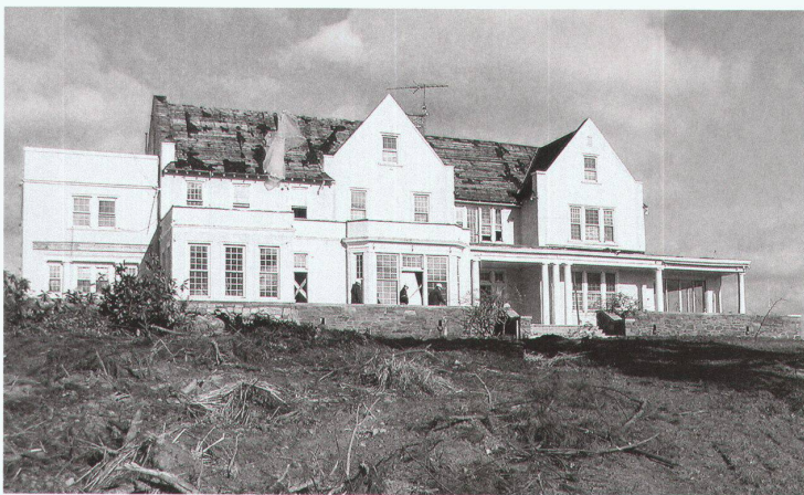
Die alte Residenz vor dem Abbruch
