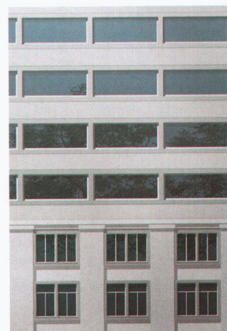
Fassadenausschnitt Krischanitz & Frank
