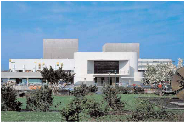
Ostansicht mit neuem Portalgebäude. Unten: vor dem Umbau
