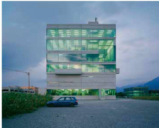
marte.marte, Bürohochhaus SIE, Lustenau (Vorarlberg) 2004
