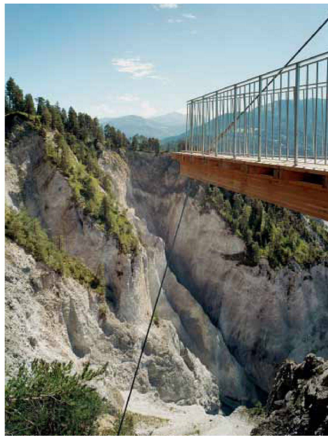
Bauherrschaft: Gemeinde Flims Architektin: Corinna Menn, Chur; Mitarbeit: Tamara Prader Bauingenieur Wettbewerb, Beratung: Christian Menn, Chur Bauingenieur Ausführung: Bänziger Partner AG, Chur Wettbewerb und Ausführung: 2005–2006
