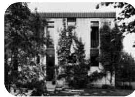
Benno und Jacqueline Fosco Oppenheim, Klaus Vogt, Siedlung auf dem Hölli, Scherz AG
