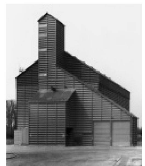
Getreidesilo, Ailly/Amiens F 2000. – Bild aus: Bernd und Hilla Becher, Grundformen industrieller Bauten, Göteborg 2004.
