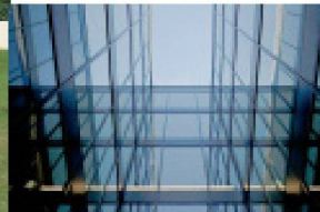
Hartmann setzt visionäre Architektur um: Fassadenbau Hartmann ist immer für Sie da: auch bei Service und Reparaturen
