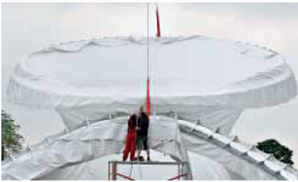
Über einer Stahlrohrrahmenkonstruktion wird die weisse Membran des Tubaloon gespannt. – Bilder: Bjørn Owe Holmberg
