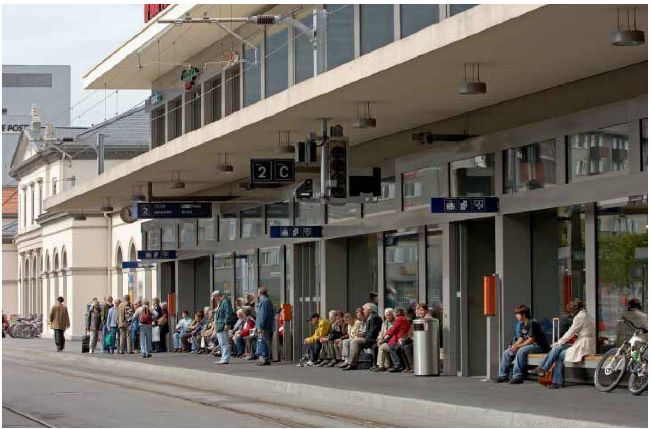
Platzseite des neuen Bahnhofstraktes
