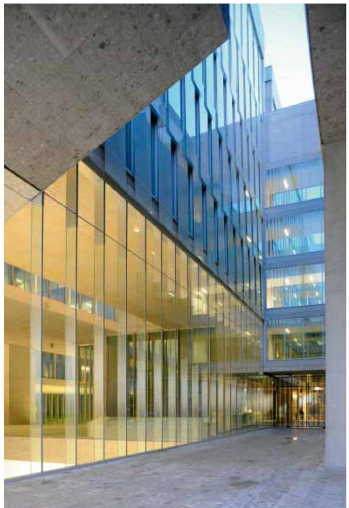
Eingesetzte und abgehängte Glasfüllungen
