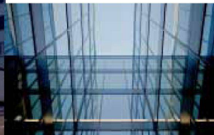
Hartmann setzt visionäre Architektur um: Fassadenbau
