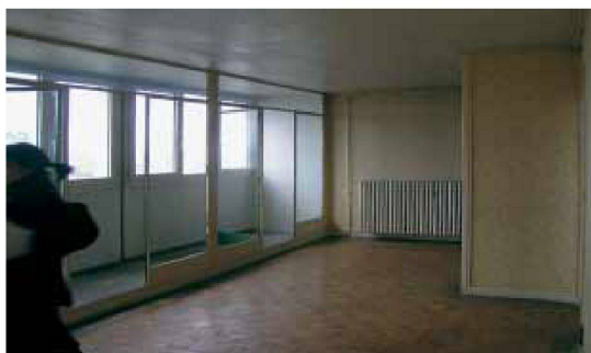
Hochhaus «Tour Bois-le-Prêtre, Blick in eine Wohnung Zustand heute und Rendering Zustand nach der Sanierung. – Bilder: © Druot, Lacaton & Vassal
